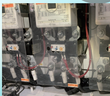
変流器(CT)取付 (制御盤内へ)
