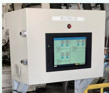
ポンプモニタ装置取付
