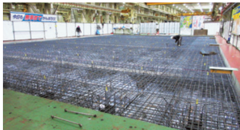
御殿場工場第1工場改築工事の様子
