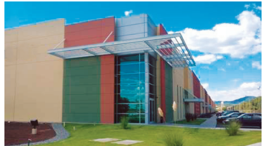
メキシコ支店が入居している建屋外観
