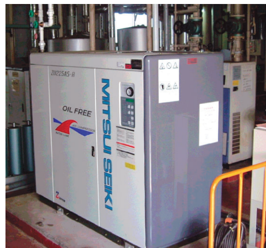
エアコンプレッサーを小型化 効果：CO 2 排出量を35%削減 69千kWh/年削減 7（t-C）/年削減
